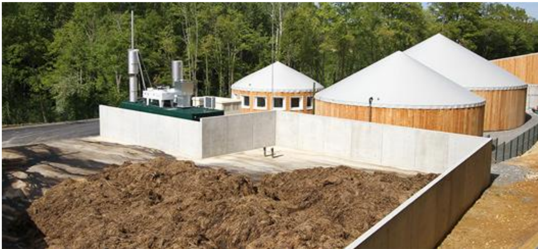
production de biogaz. Source : connaissance des énergies
