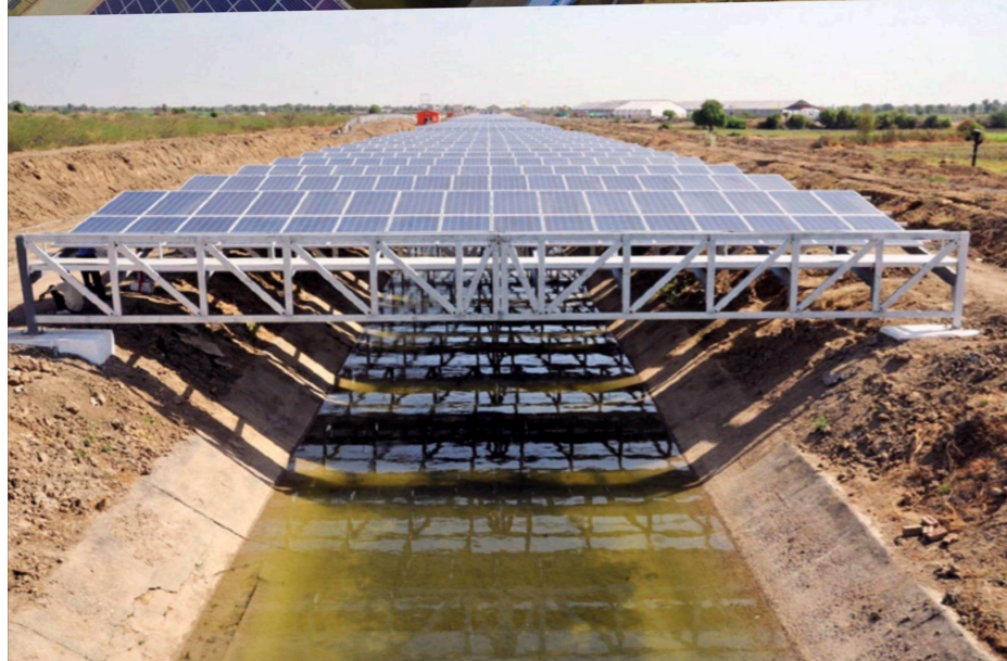
Panneaux solaires au-dessus d'un canal, Inde
